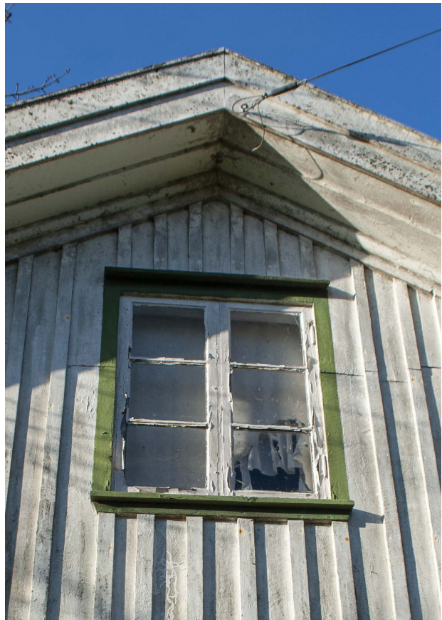
Vindsfönstret mot öster är av höger och kan vara original. Det bör stå som förebild för nya fönster i byggnaden.
