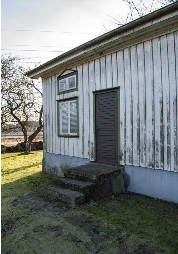
Vid dörren till drängstugan finns en äldre stentrappa som bör tas med till det nya läget.
