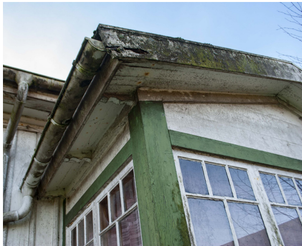
Taktassarna på verandan är dekorativt utsågade, ett utseende som bör bevaras eller återskapas.
